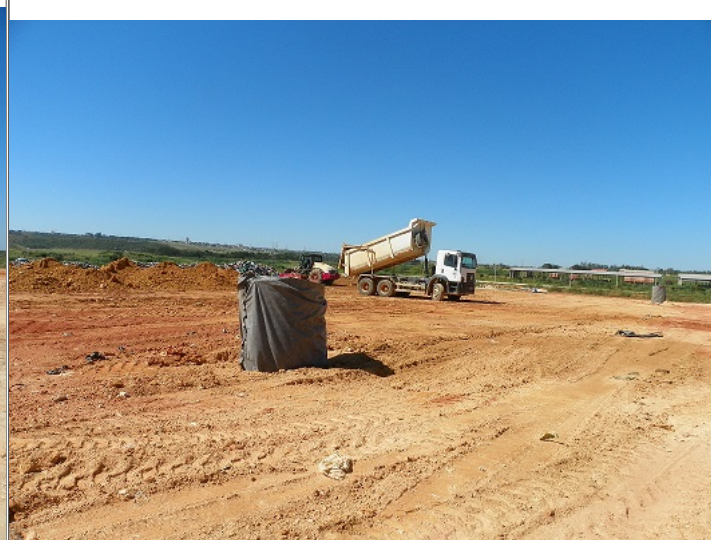
FOTO 6: Dreno vertical devidamente coberto e chegada de caminhão para descarga de resíduos.
