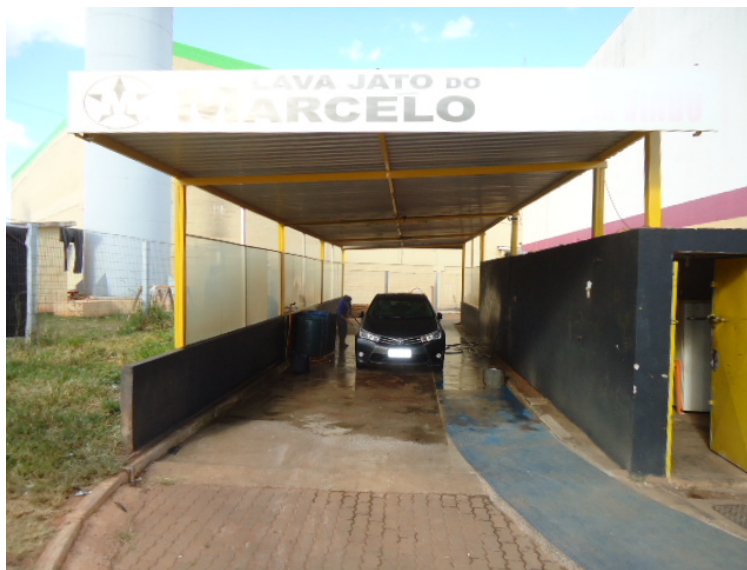
Foto 6. Área de lavagem de veículos sem canaletes.
