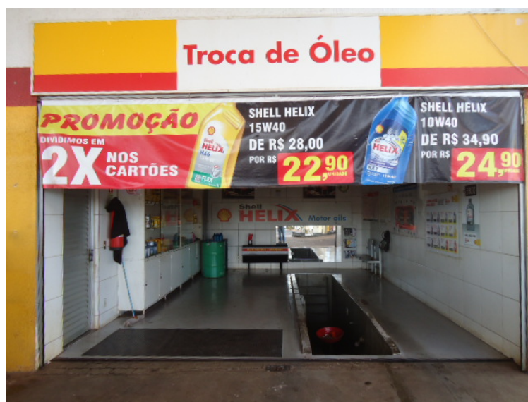
Foto 7. Área de lubrificação de veículos com 1 vala e 1 tanque de OLUC, contidos em canaletes.
