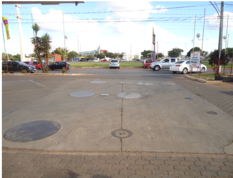
Foto 8. Área de tancagem.
