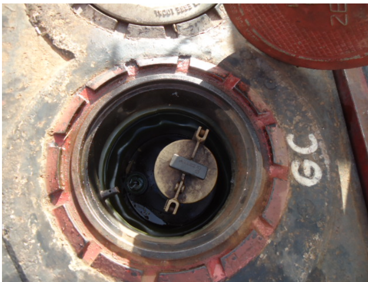
Foto 3. Descarga selada à distância sem flanges.
