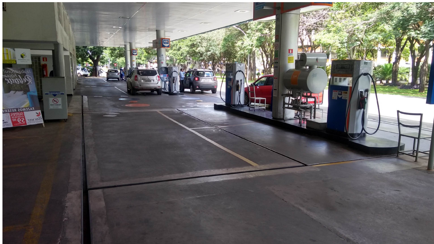
Figura 1 - Vista geral do posto.
