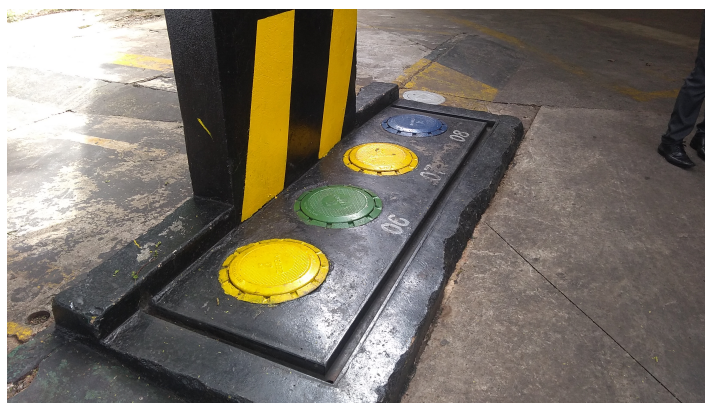
Figura 8 - Câmara de contenção das unidades abastecedoras - Sump de bomba - válvulas de retenção instaladas na linha de sucção ( Check Valve).
