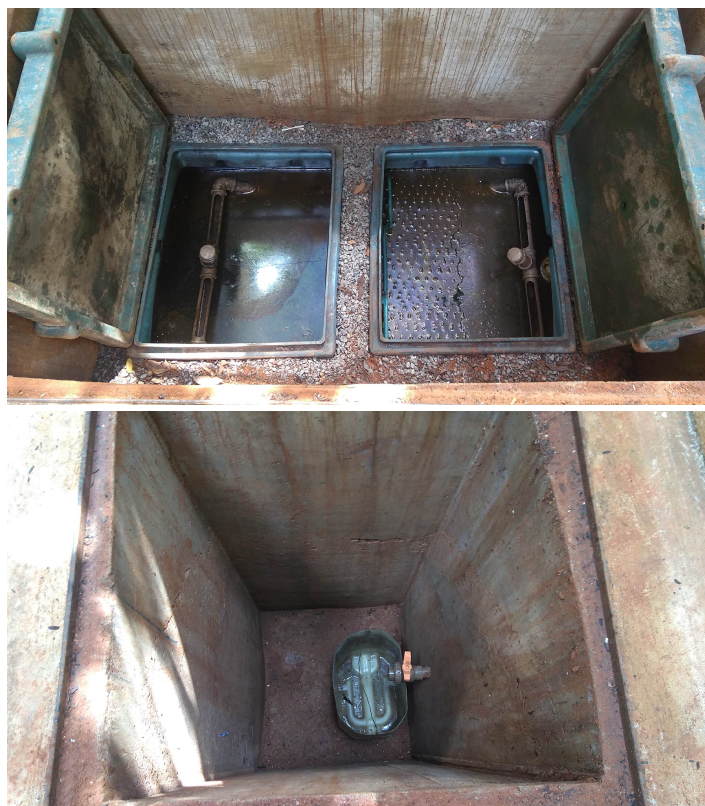
Figura 16 - Caixa separadora (esquerda) e Caixa Coletora (direita).
