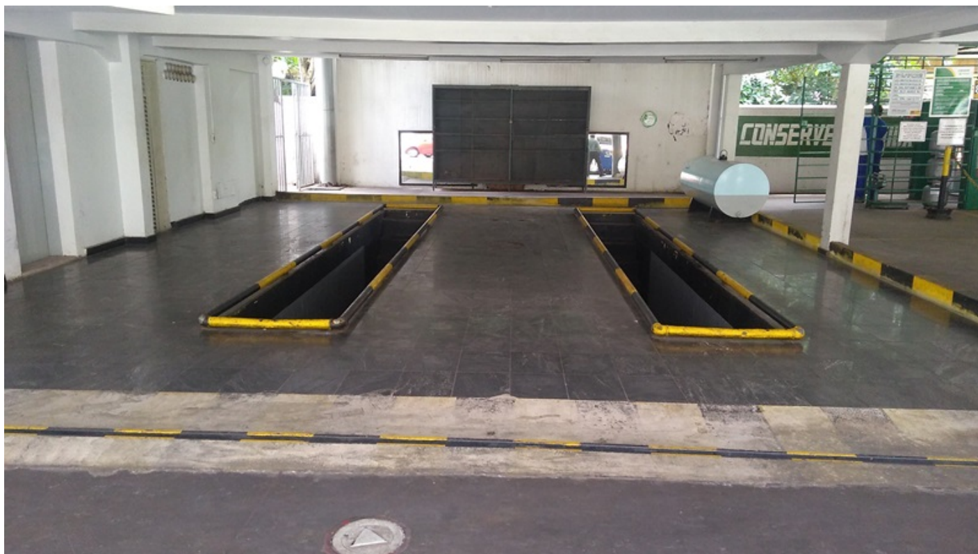
Figura 11 - Área de lubrificação de veículos (desativada).
