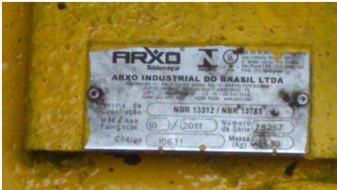
Figura 3 - Placa de identificação de um dos tanques subterrâneos para armazenamento de combustíveis.
